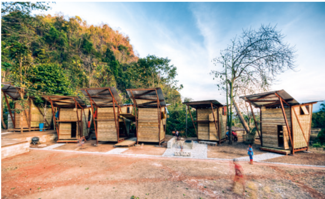
Safe Haven (« le refuge ») - Orphelinat. Tyin Tegnestue Architects Ban Tha Song Yang, Noh Bo, Thaïlande, 2009 Maître d'ouvrage: orphelinat Safe Haven avec le concours de l'université de Trondheim (NTNU), professeurs Sami Rintala et Hans Skotte; Ole Jørgen Edna © Pasi Aalto
