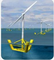
Grâce au projet Winflo, des éoliennes offshore seront bientôt implantées plus au large, là où les fonds marins peuvent atteindre jusqu'à 200 m de profondeur. Les turbines actionnées par deux pales reposeront sur des plateformes semi-submersibles flottantes. Cette technologie française sera testée au large du Croisic (Loire-Atlantique) en 2014.
