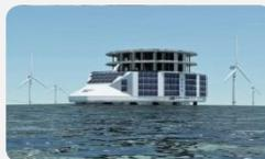
Une entreprise française a développé un concept de structure flottante de 200 mètres de long et de 90 de large, intégrant quatre sources d'énergies renouvelables (éolien flottant, hydrolien, houlomoteur et solaire), pour générer un volume significatif d'électricité en jouant sur leur complémentarité.
